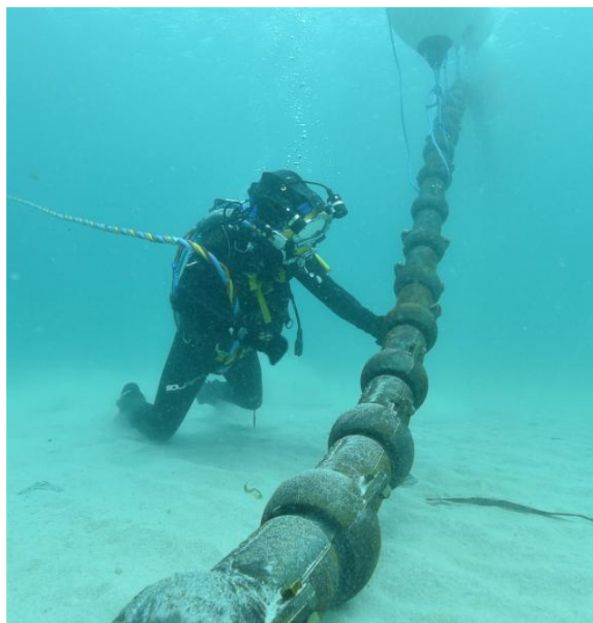
Figura 3.11. Esempio di metodo di posa con gusci di protezione
